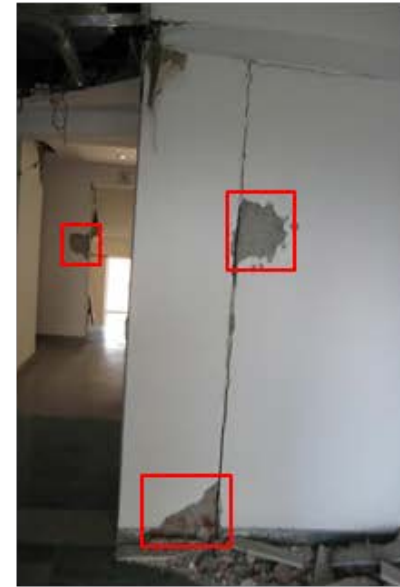
Spalling
