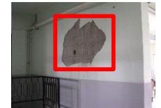
Spalling
